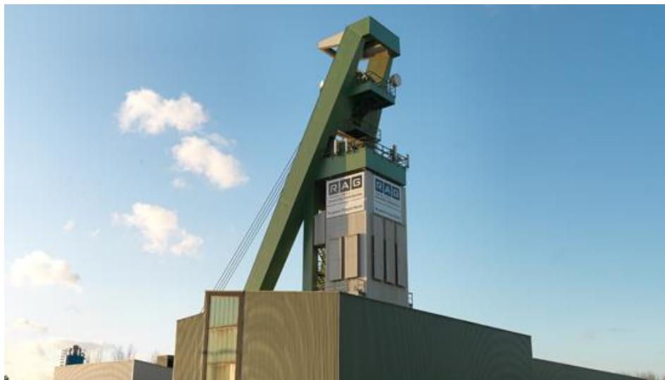
Abbildung 1 - Fördererturm des Bergwerks Prosper-Haniel, Bottrop, Quelle: RAG AG
